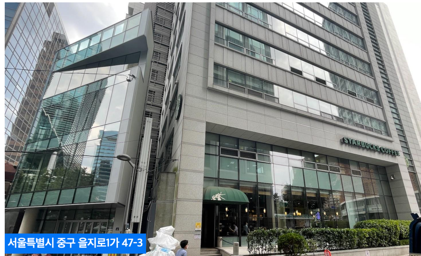
4층 전면 통유리 신축 건물
