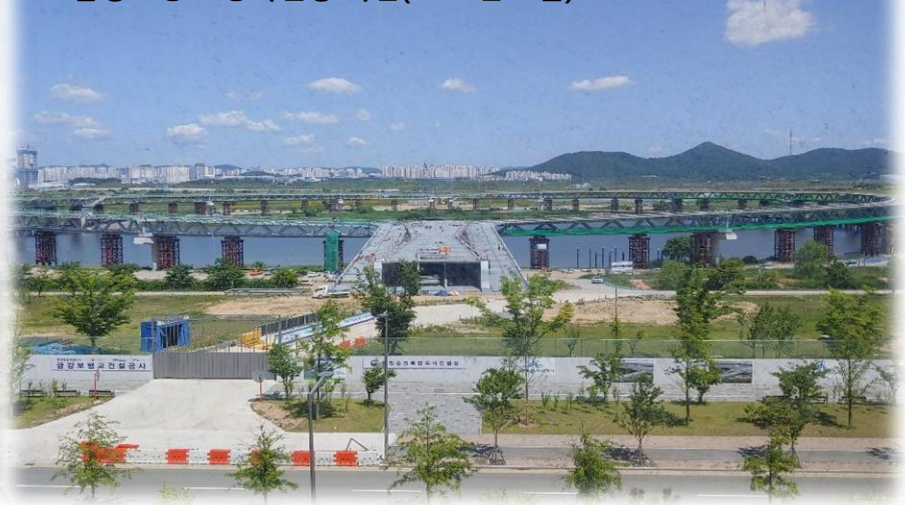
금강보행교 공사현장 사진(2020년10월)
