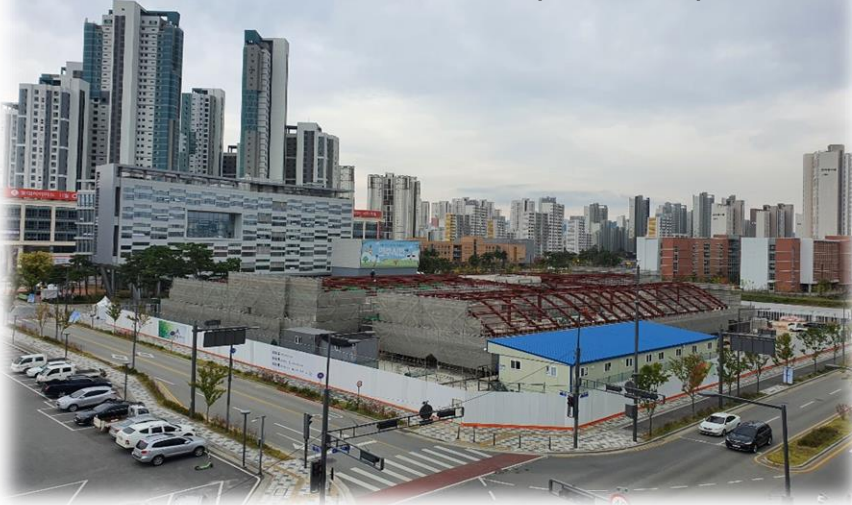
세종세무서 공사현장 및 세종교육청 사진(2020년10월)
